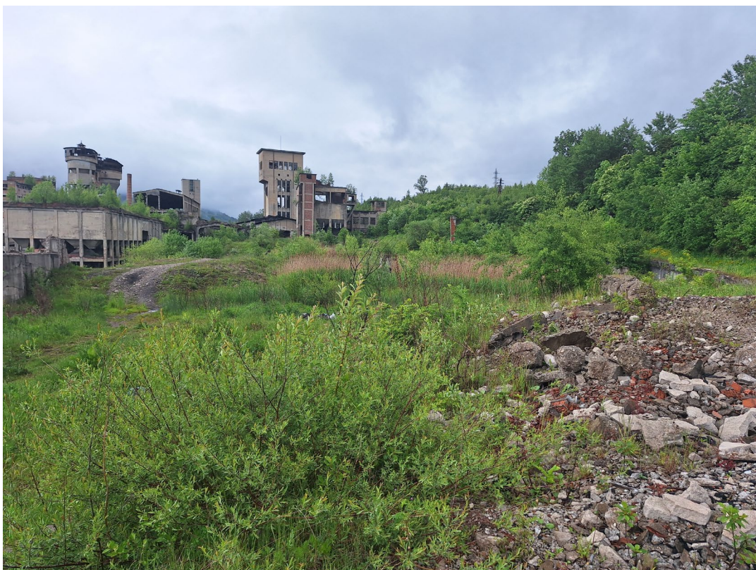
Fost bazin de decantare (centru), colmatat și cu vegetație tipică de zone umede, mlăștinoase și depozite neconforme de materiale de construcții și alte resturi (dreapta)
