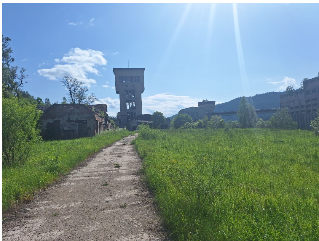
Platoul superior, drum de acces din beton parțial deteriorat, vedere către V spre Turnul Puțului Centru.
