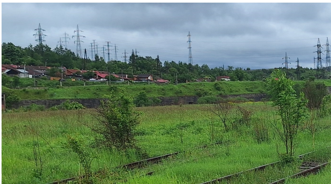
Zid sprijin taluz inferior
