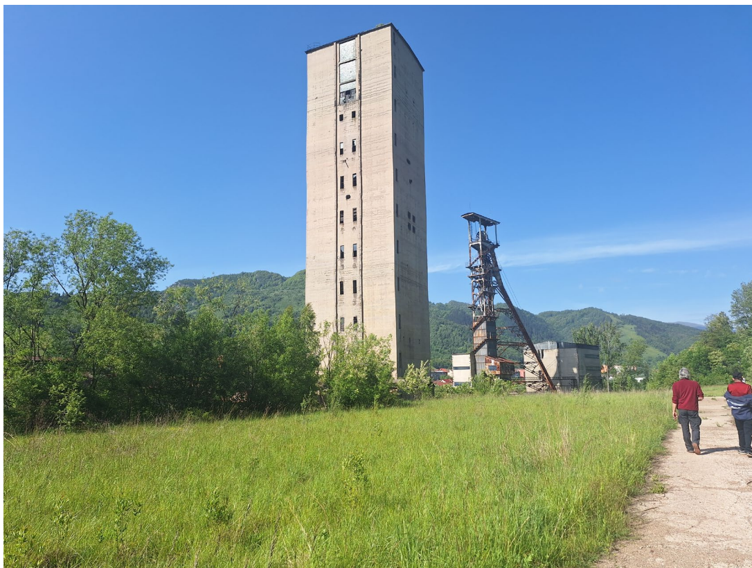
Platoul superior, drum de acces din beton parțial deteriorat, vedere către E din dreptul minei Deak.
